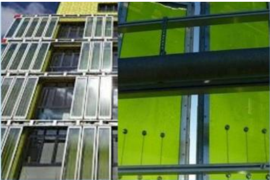
Edificio BIQ (siglas de «Bio-Intelligent Quotient», cociente bio-inteligente), un edificio residencial en Hamburgo, Alemania
