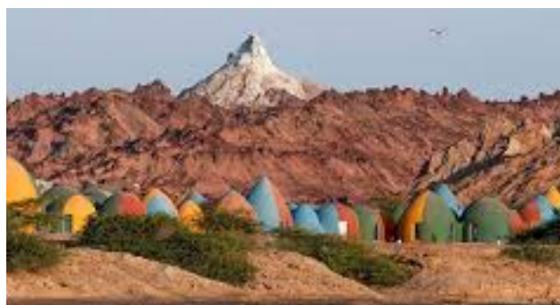
Construidas con la técnica de super adobe por la firma ZAV Architects, desarrollada por el arquitecto nacido en Irán Nader Khalili.
